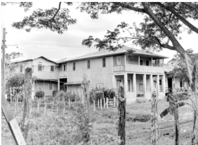
Casa de La Paloma, nombre que se le daba a la edificación, debido al bar que se encontraba en la planta baja.
