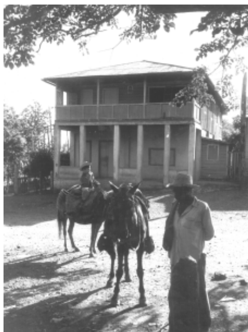
Vista frontal de La Paloma, lugar al que la familia Castro Ruz fue a vivir, en 1954, tras el incendio, de la casa principal.
